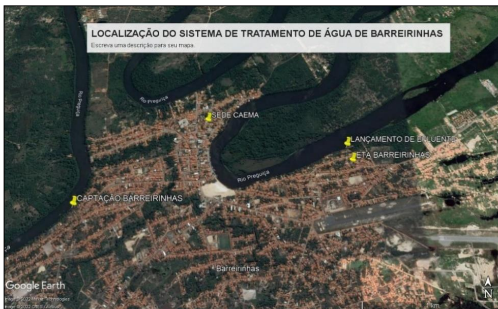
Figura 3: Localização do Sistema de Tratamento de Água de Barreirinhas (MA)
