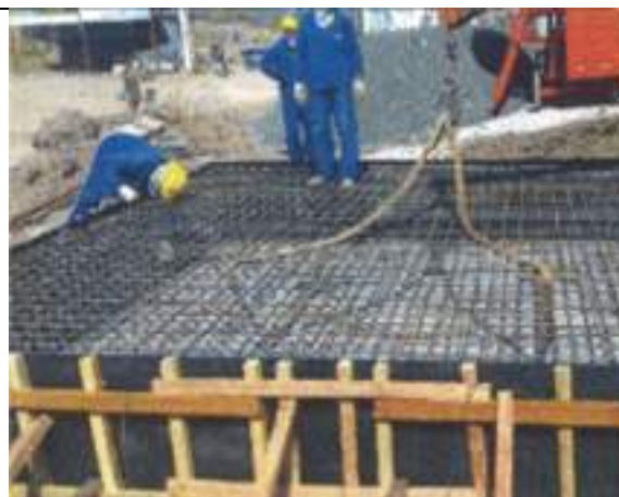
d) Montagem da armadura;
