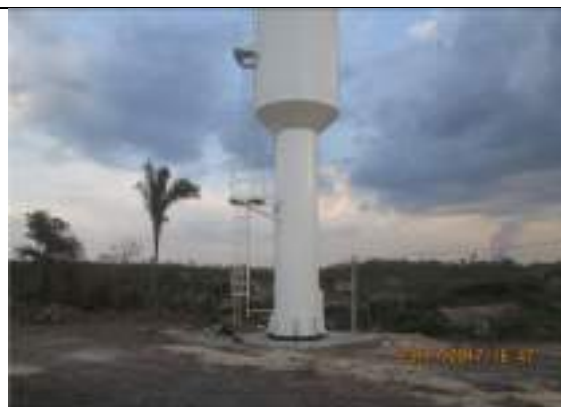
f) Instalação do reservatório
