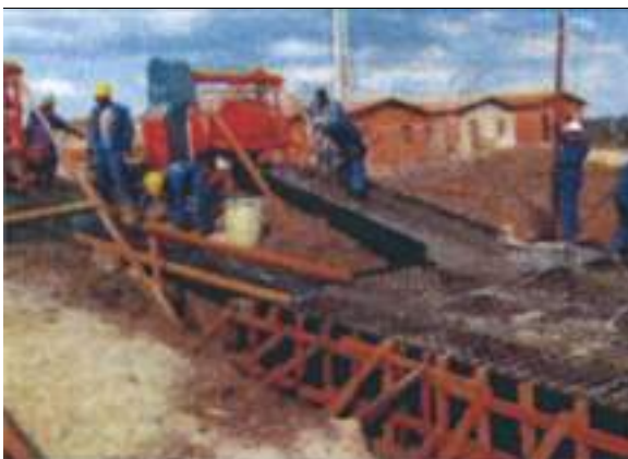
e) Concretagem da base;
