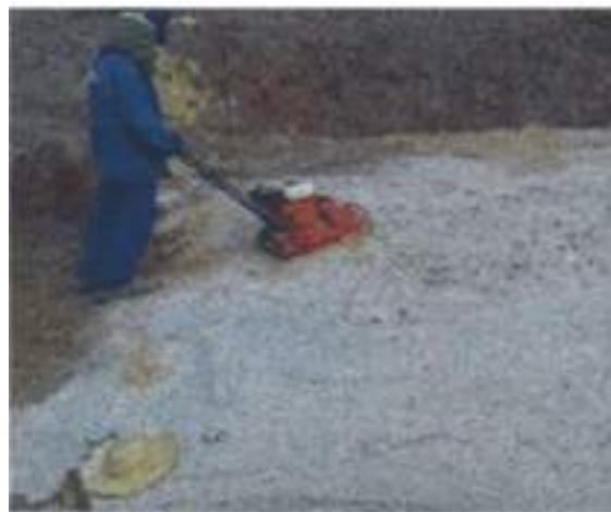
b) Escavação e melhoramento do solo;
