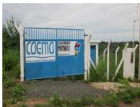
b) Poço perfurado
