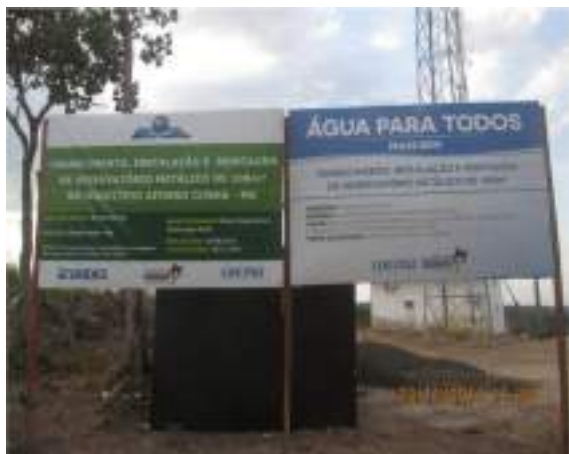
a) Instalação da placa da obra e de barracão;
