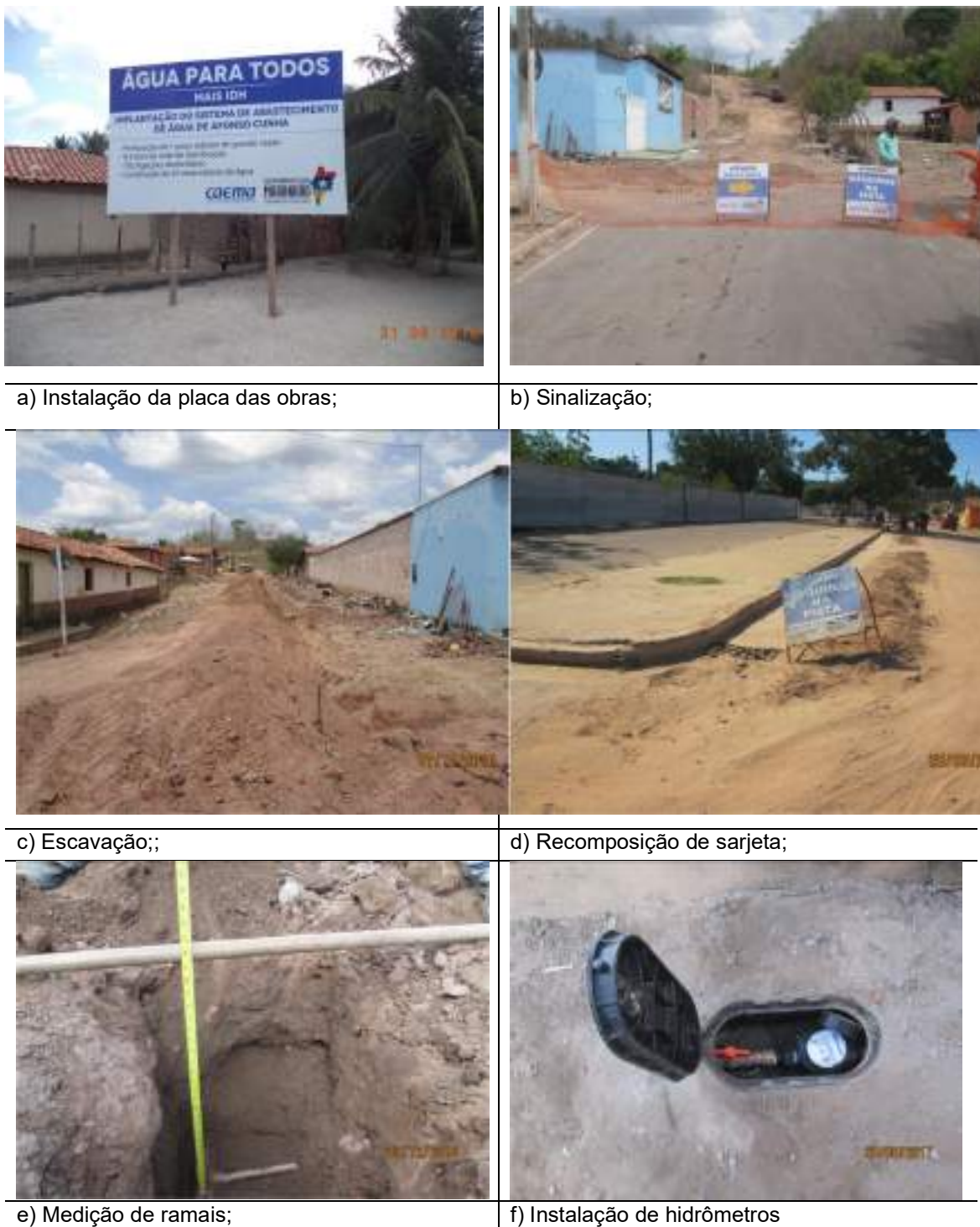
Figura 10 - Execução da rede/adutora
